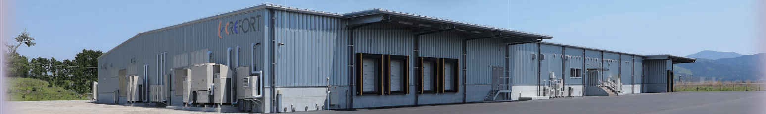
小山町 食品工場 設計施工（鉄骨造平家建 4,200 m 2 ）
